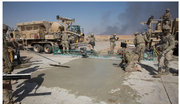
Remise en état de la piste de Q-WEST
