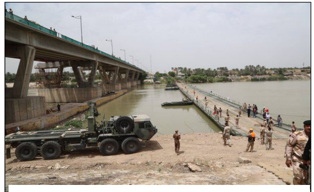
Mise-en-œuvre d'un pont flottant en Irak
